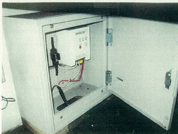
避雷装置取り外し 据付調整
