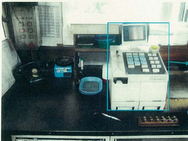
料金收受装置取り外し 据付調整
